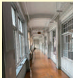
アーチ形の天井廊下
