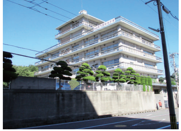
現在の山口県総合庁舎の遠景
